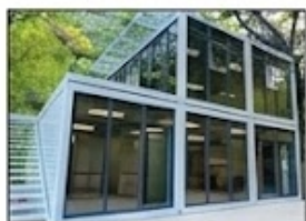
Muro Cortina de Vidrio
